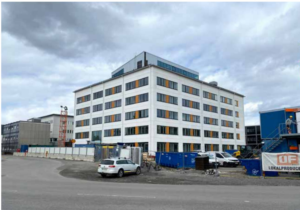
I augusti 2021 kunde förbundet flytta in i en så gott som färdigställd nybyggnad inom Region Västerbotten.
